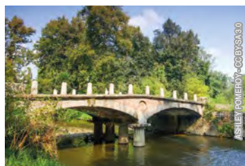
Ponte sul Lambro
